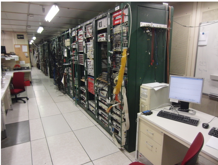
Rys.: Pomieszczenie zbierania danych - Counting House
